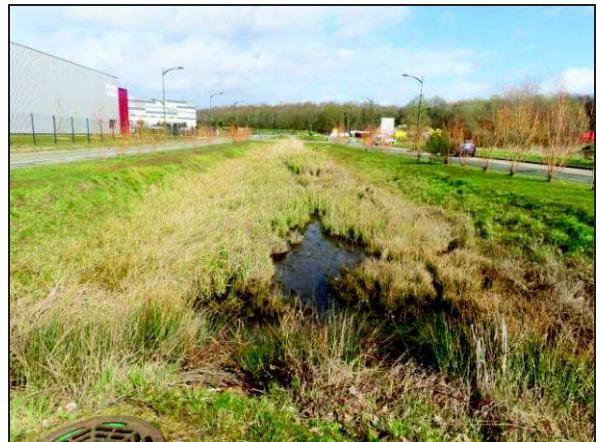
4-Noue d'eaux pluviales (mars 2021)
