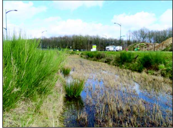
8- Noue d'eaux pluviales (mars 2021)
