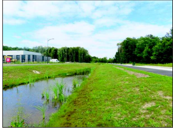
14- Noue d'eaux pluviales (juillet 2021)
