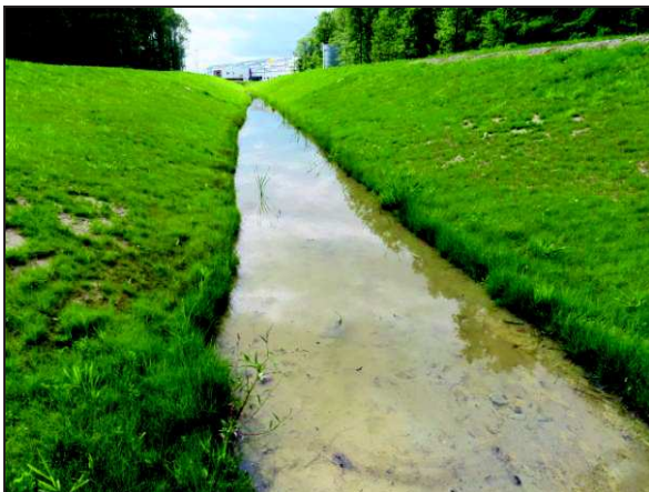
11- Noue d'eaux pluviales (juillet 2021)
